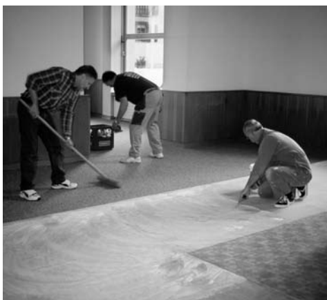
Im Esszimmer werden neue Teppiche verlegt.
