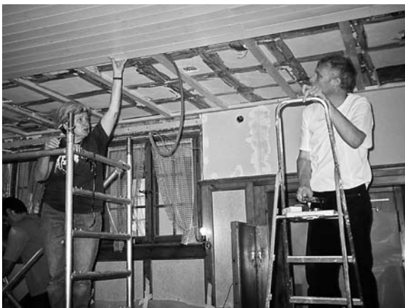
Die neue Decke im Gruppenraum wird montiert
