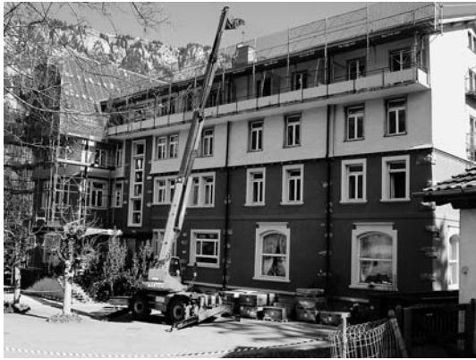
Das Dach wird neu gedeckt – in schwindelnder Höhe
