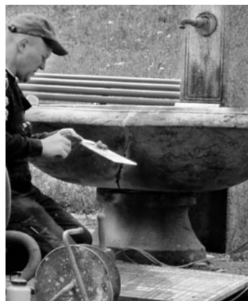
Noch schnell einen Graben für das neue Stromkabel zum Chalet Enzian ... und Zement für den Riss im Brunnen
