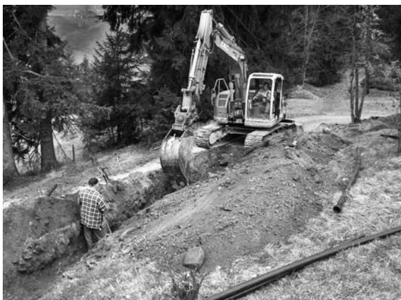
Noch schnell einen Graben für das neue Stromkabel zum Chalet Enzian ... und Zement für den Riss im Brunnen
