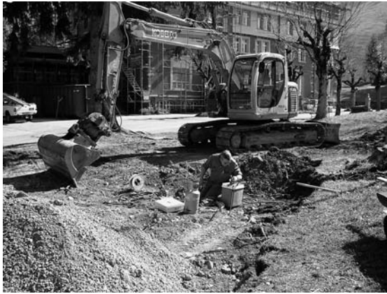
Sicherheit auf dem Spielplatz: Aushub für Fallschutzplatten.
